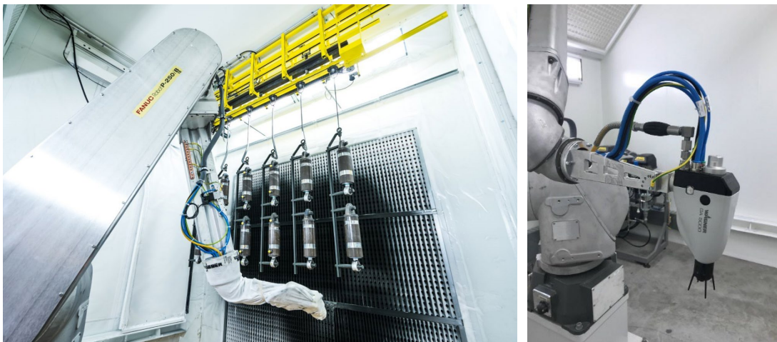
Gronden in de automatische spuitcabine met het GA 5000 EAC elektrostatische AirCoat pistool
